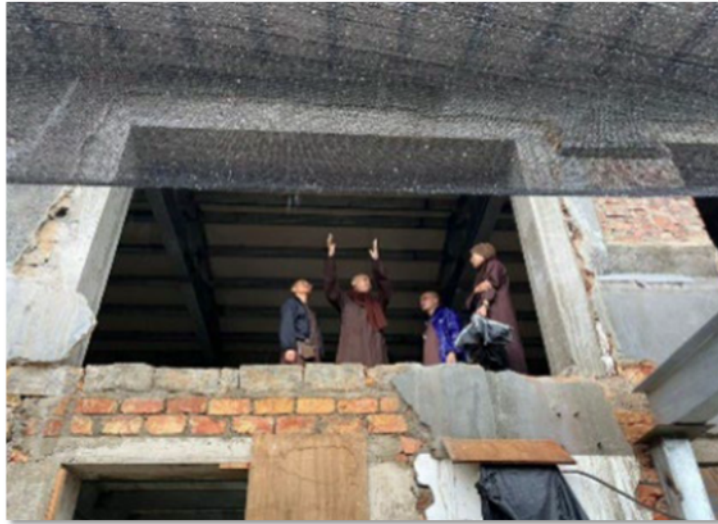
1 st Floor, before reconstruction 重建前的一樓
