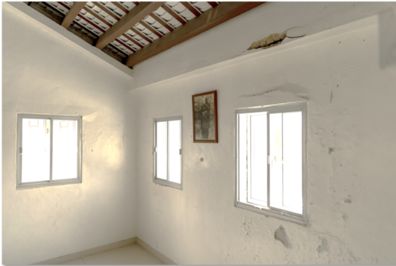
1 st Floor, before reconstruction 重建前的一樓
